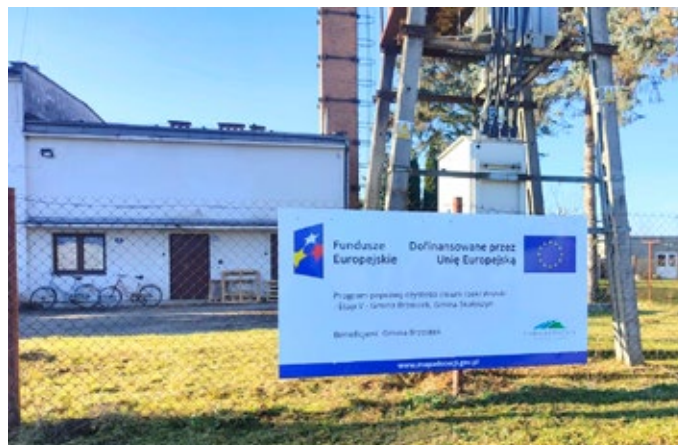
Obecny budynek SUW w Brzostku wraz tablicą informującą o dofinansowaniu zadania z funduszy europejskich
