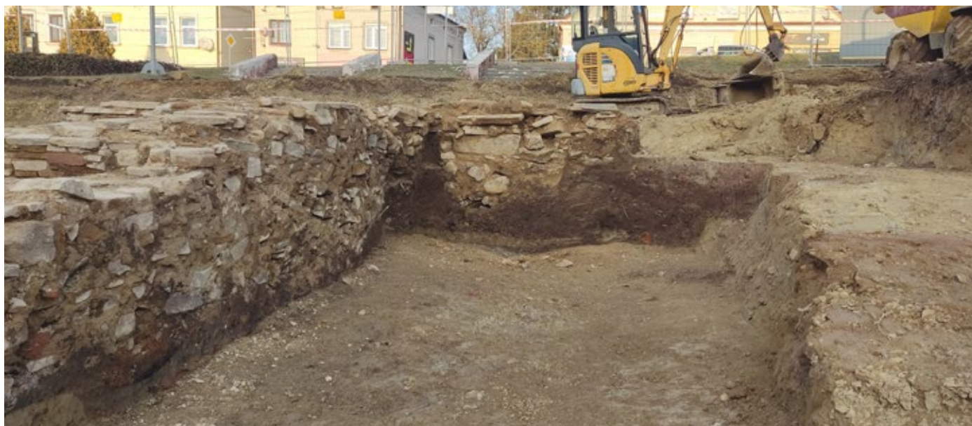
Pod fundamentami widoczna ciemna warstwa - ślad po najstarszym ratuszu spalonym przez Węgrów w 1474 r.
